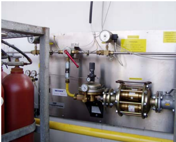
Central de regulación para 150 m 3 /h de acetileno (para grandes consumidores)
