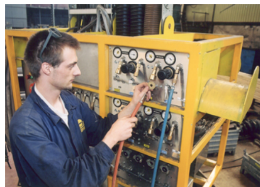
Puestos de trabajo centrales y cerrados – MECS en un astillero
